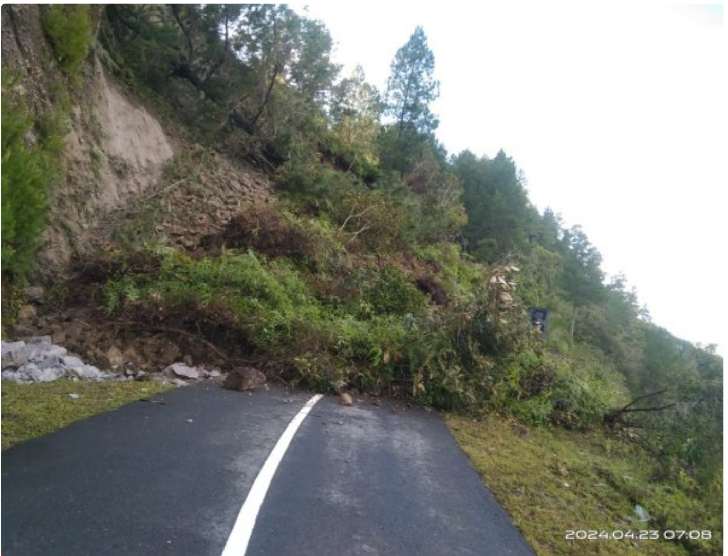
Longsor di kecamatan Rongkong
